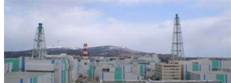
Rokkasho Reprocessing Plant (JNFL)
