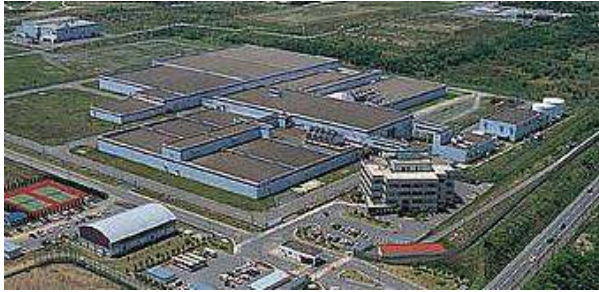
Rokkasho Enrichment Plant (JNFL)
