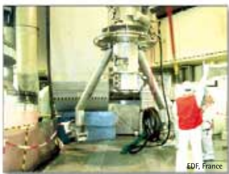
Robot d'inspection à la centrale nucléaire de Bugey, France.
