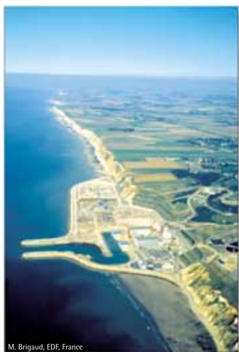
Vue de la centrale nucléaire de Penly, France.
