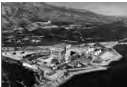
Vandellós-I avant son démantèlement.
